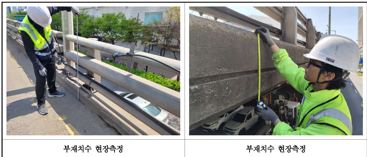
【사진 2.1】 부재 현장측정 전경
